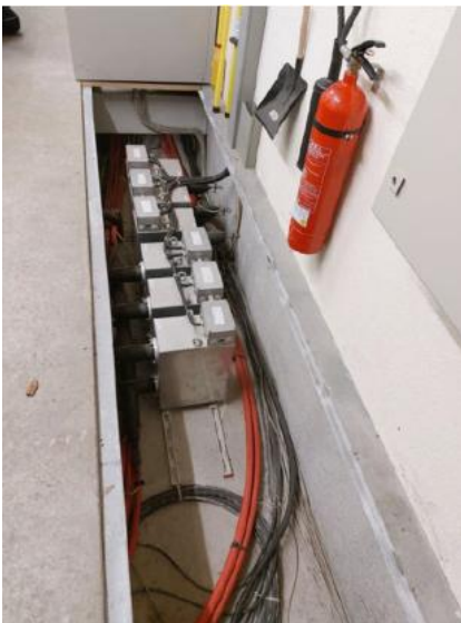
Abbildung 1 Kombiwandler im Kabelkeller
